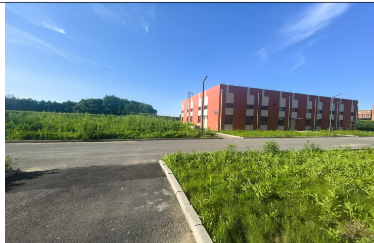
项目北侧照片
