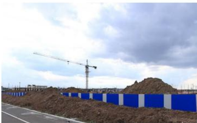
西侧 在建厂房
