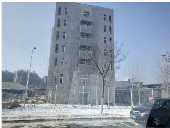
项目西南侧：春原汽车电线公司
